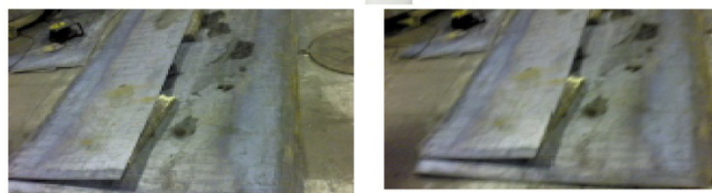
Рисунок 11. Толстостенные листы для рельс по которым ездит кран.
